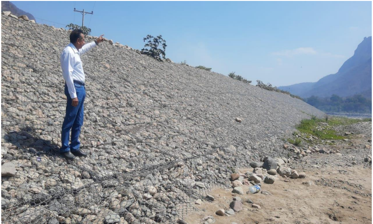
Supervisión de Obras de defensas ribereñas en el Cauce del Río La Leche
